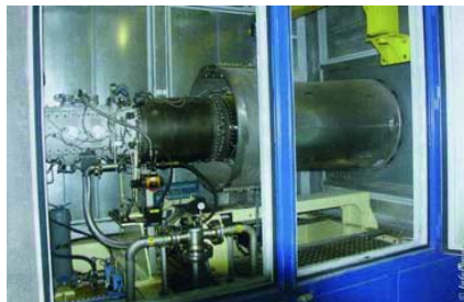
Figura 6. Turbina de gas de 3,8 MW. Papelera del Oria.
