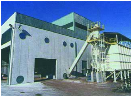
Planta de aprovechamiento de residuos forestales en Allariz. Cortesía de InfoPower. Nº 59. Septiembre 2003.
