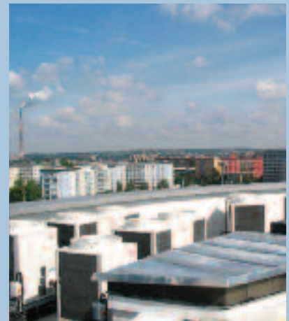
Instalación de las unidades exteriores sobre el techo
