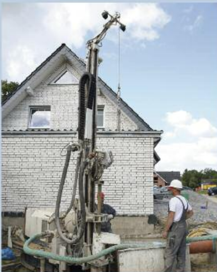
Perforación de sondas terrestres
