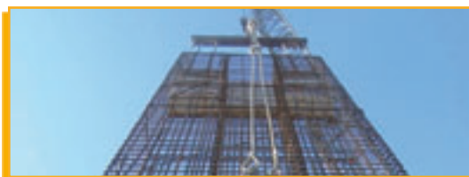
Ejecución de un tramo de muro pantalla termoactivo, sistema ENERCRET. Fuente: ENERES-ENERCRET
