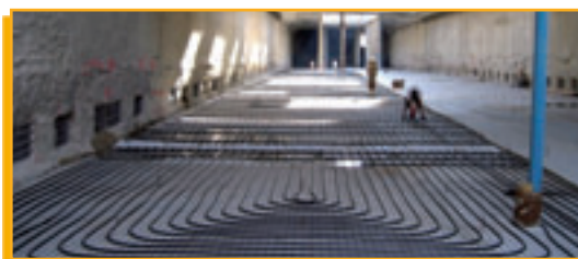
Ejecución de un tramo de losa termoactiva, sistema ENERCRET. Fuente: ENERES-ENERCRET
