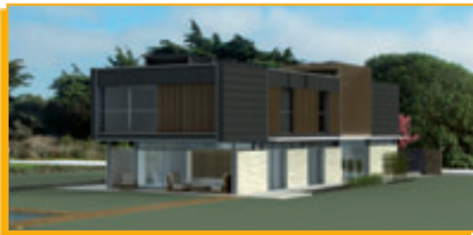
Instalación geotérmica en una vivienda unifamiliar en Pozuelo de Alarcón
