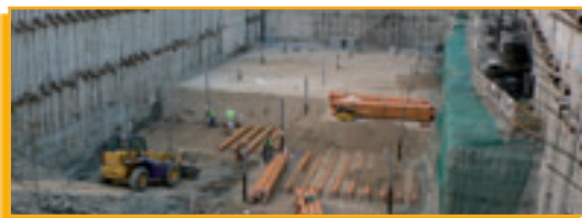
Ejecución de los intercambiadores geotérmicos verticales del sistema de climatización y los intercambiadores geotérmicos horizontales del sistema de pretratamiento del aire de renovación. Fuente: Eneres
