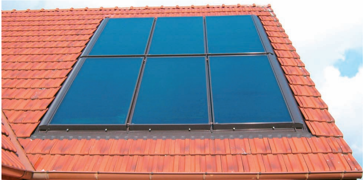
Fig. 56: Ejemplo práctico para la aplicación de colectores planos
