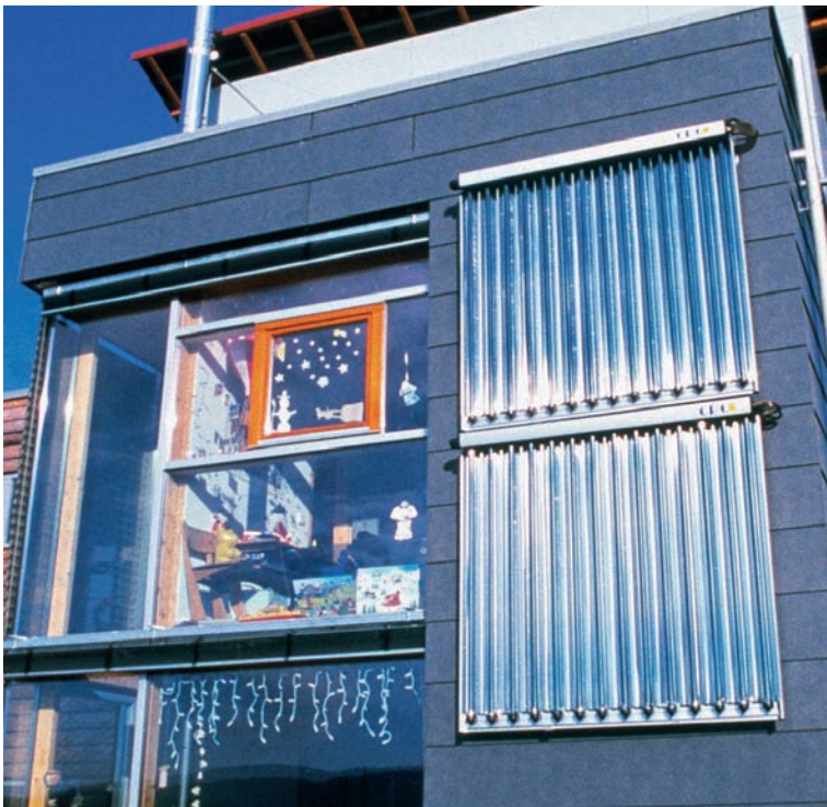
Fig. 53: Ejemplo práctico para la aplicación de colectores de tubos de vacío
