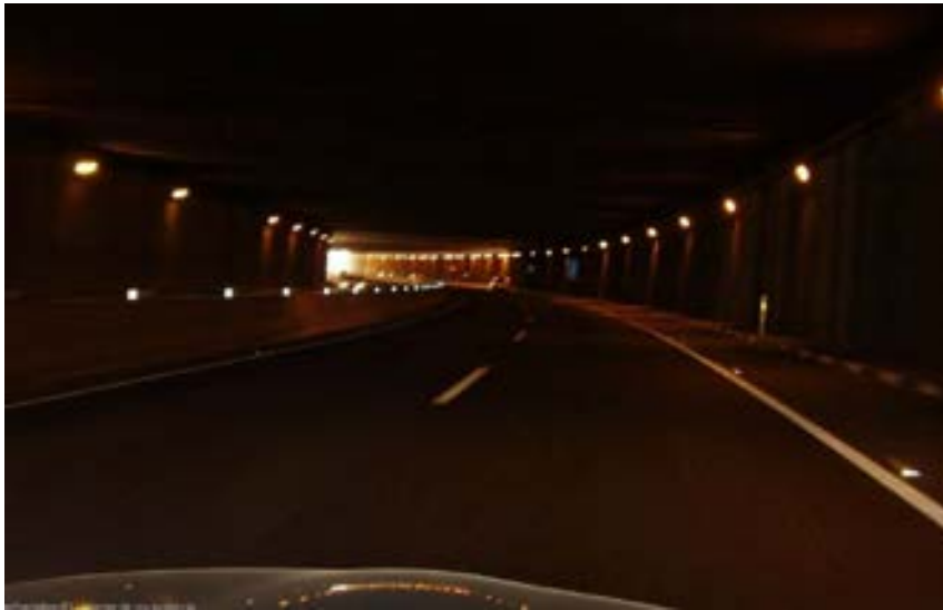
Figura 8.2. Interior del túnel.
