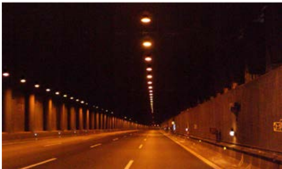
Figura 3.17. Tramo de un túnel de la M40 VSAP.
