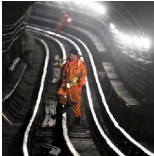
Figura 4.21. Trabajos de mantenimiento en el túnel. Metro de Londres.
