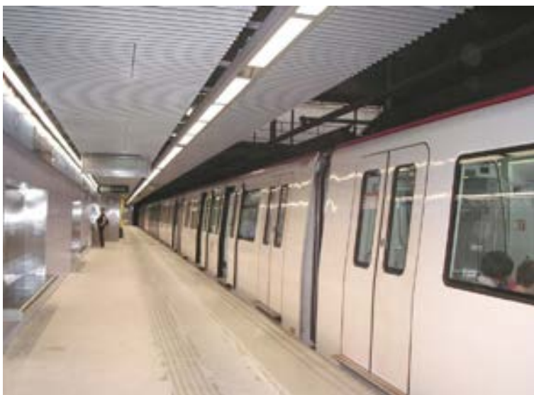
Figura 1.2. Estación del Metro de Barcelona Línea 5. Fuente: Lledó SA.
