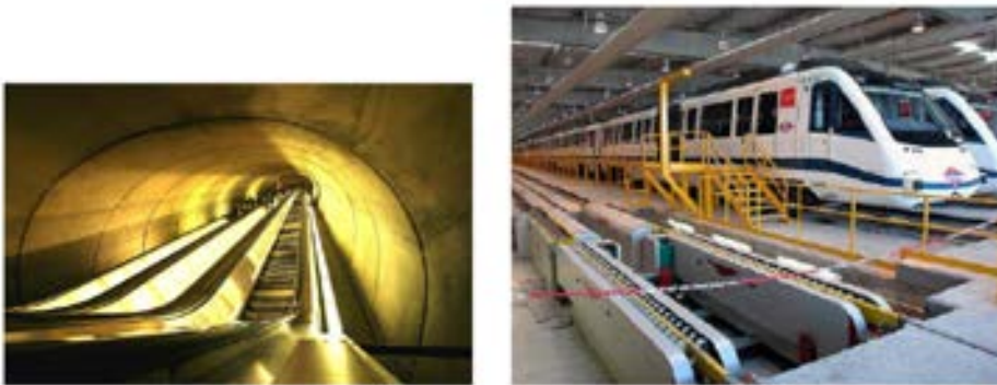
Figura 4.7. Movilidad de las personas y talleres del Metro de Madrid.
