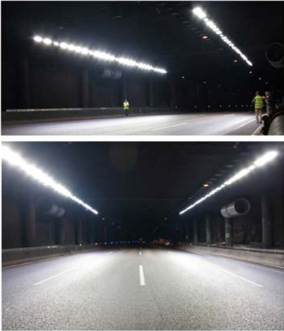
Figura 8.14. Túnel después de la ejecución de las mejoras.
