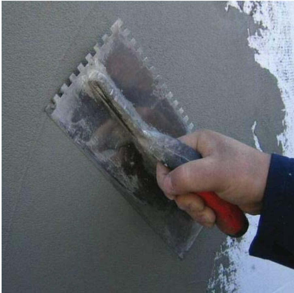
Previo a la colocación de la malla, las placas se revisten con una primera capa de mortero, llamada capa base, de aproximadamente 1 a 2 mm de espesor.
